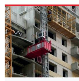
Грузовые подъемники используются при строительстве с высокими требованиями к транспортировке материала, на стройках высотных зданий, мостовых опор. Подъемники сконструированы и изготовлены, чтобы работали длительно и надежно. Длина кабины подъемника предусмотрена с 3 000 мм до 3 800 мм.
