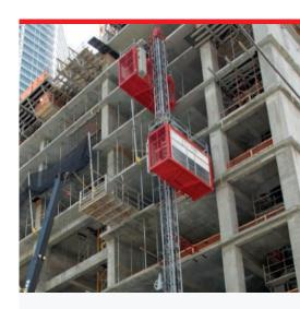
Строительные подъемники используются при строительстве с высокими требованиями к транспортировке пассажиров и материала, на стройках высотных зданий и мостовых опор. Подъемники спроектированы и изготовлены, чтобы работали длительно и надежно. Подъемник поставляется также в исполнении ДУО (две кабины на одной мачте).
