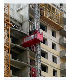
Грузовые подъемники используются при строительстве с высокими требованиями к транспортировке материала, на стройках высотных зданий, мостовых опор. Подъемники сконструированы и изготовлены, чтобы работали длительно и надежно. Длина кабины подъемника предусмотрена с 3 000 мм до 3 800 мм.
